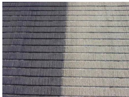
Figura 13 - Representação de faixa de pista com groove (AIRPORT TECHNOLOGY. *Jetting Systems*, 2014).
